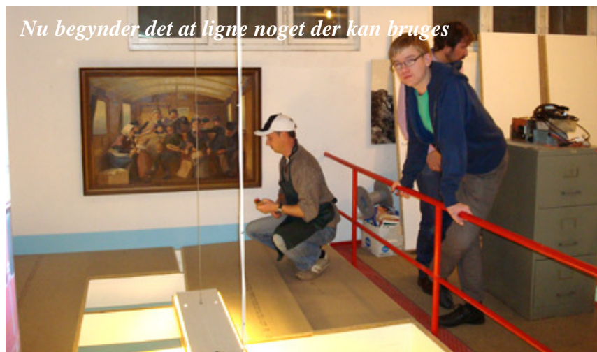
Der bygges på det nye værkstedsgulv
